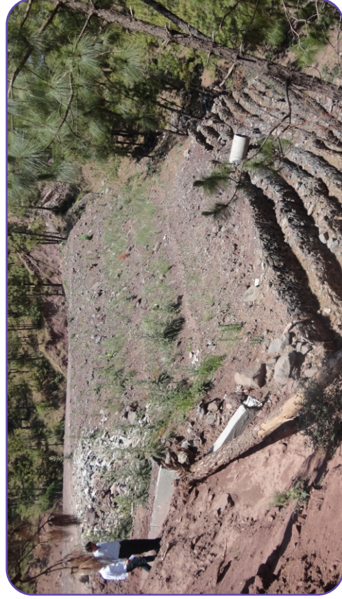
(Hedge Brush Layer : Sungal-Nog Road, Disstt. Bilaspur, Chainage 02+525)
