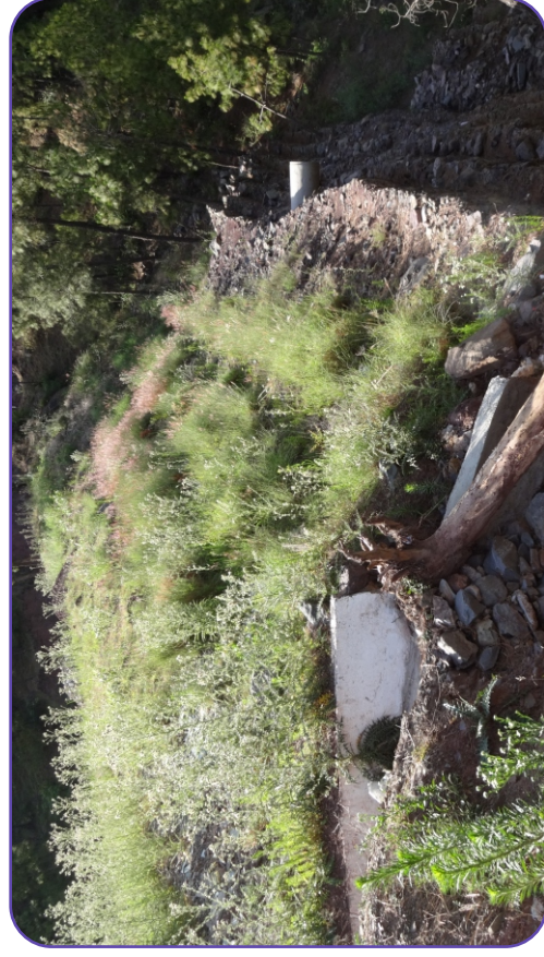
(Hedge Brush Layer : Sungal-Nog Road, Disstt. Bilaspur, Chainage 02+525)
