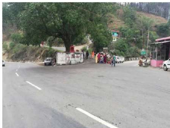
End Point of Existing road Km 28/444 (Kalkhar)
